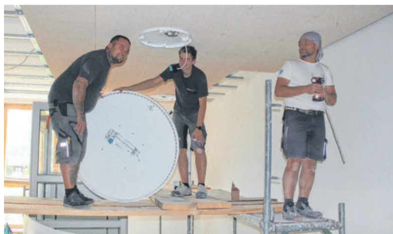
Noch wird an der Sanierung der Schule mit Hochdruck gearbeitet. Der Kindergartenstrakt ist inzwischen fertiggestellt. STR
